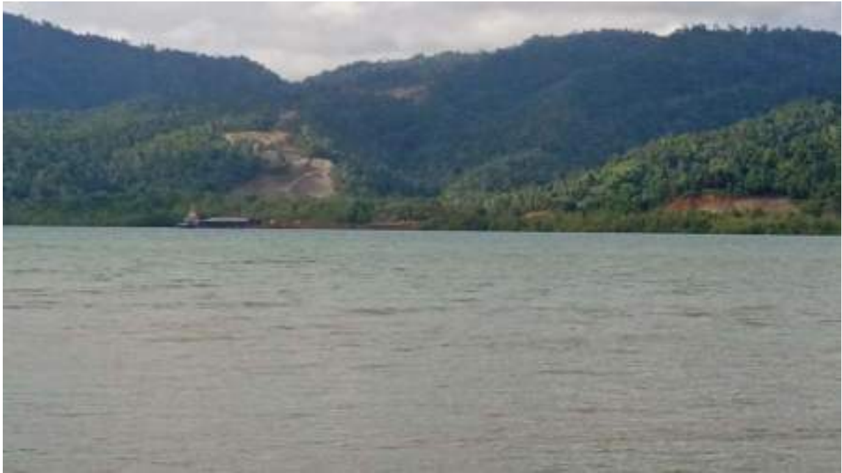
Lokasi pembangunan pelabuhan bongkar muat hasil pertambangan nikel di Desa Siuna, Kecamatan Pagimana (Mediabanggai.com/ Dewi Noviyani Satri)
