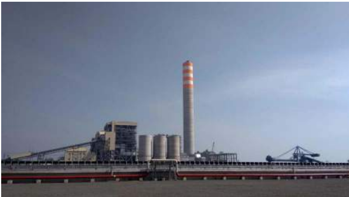
Potret proyek PLTU Batang yang diinisiasi PT Bhimasena Power Indonesia, konsorsium Grup Adaro dengan JPower dan Itochu asal Jepang. (Dok. SCG CBM Indonesia)
