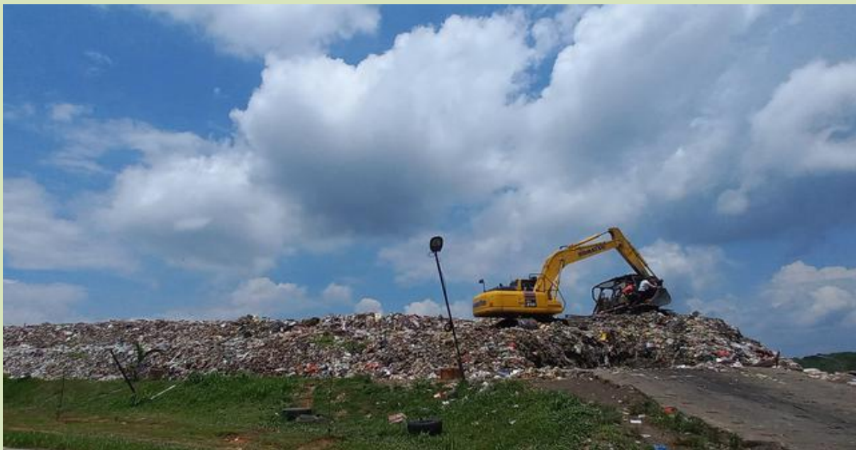
Alat berat sedang mengaduk sampah di TPA Talang Gulo Sanitary Landfill Kota Jambi, Rabu (24/8/2022). TPA baru yang mendapat pendanaan dari KFW Jerman ini diproyeksikan menghasilkan sumber energi alternatif. (Liputan6.com/Gresi Plasmanto)
