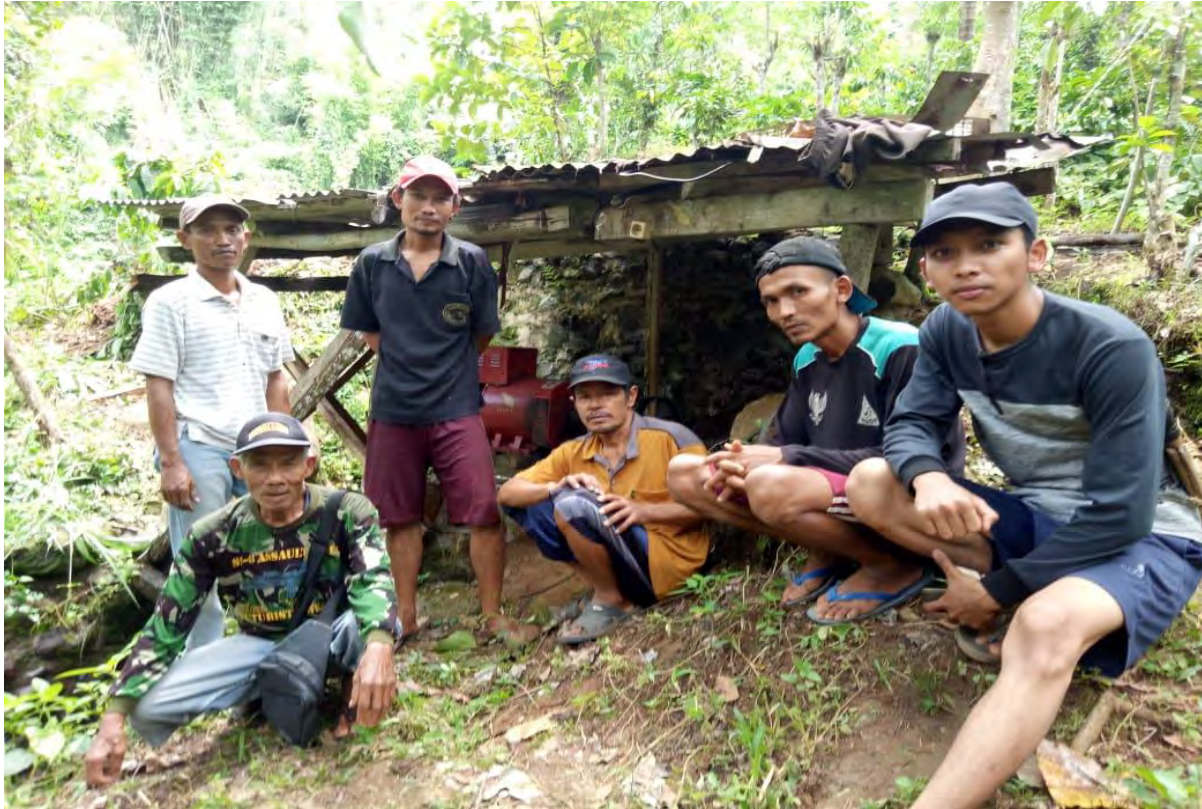
Suratman mengecek kondisi generator turbin PLTMH di desa setempat. Lampost.co/Setiaji Bintang Pamungkas
